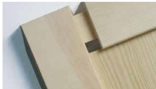
Assemblage par tenon et mortaise
